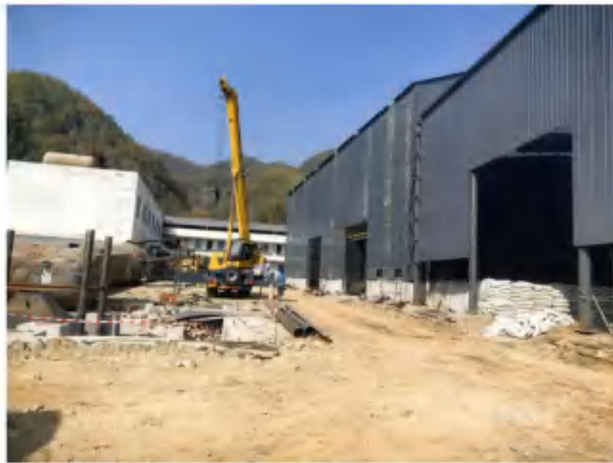
项目厂区现状
